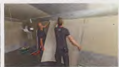
▲ Hier wird der Kabineninnenraum mit hellem Kunstleder verkleidet
